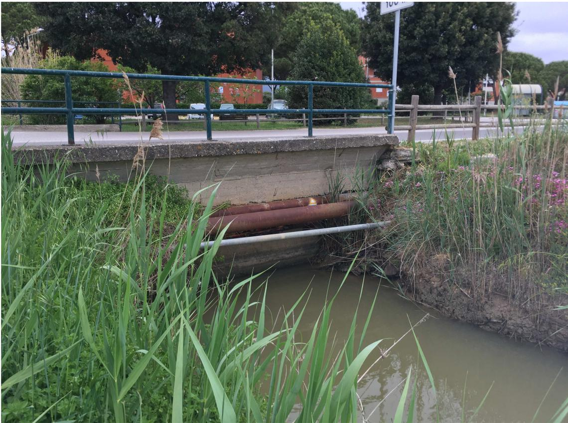
Vista in dettaglio dell'attraversamento da valle con le tubazioni completamente rigurgitate in condizioni di asciutto
