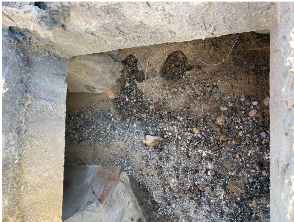
Foto 16 – Pozzetto acque chiare esistente con detriti da rimuovere anche dalle tubazioni
