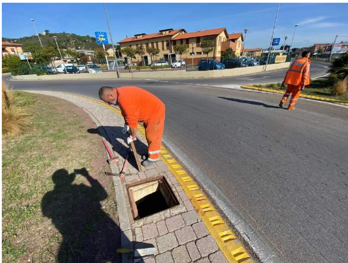
Foto 15 – Pozzetto acque chiare esistente da sostituire con FB7
