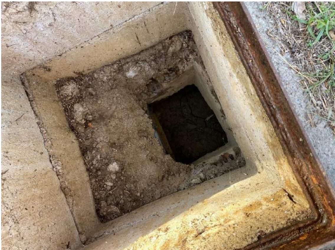
Foto 12 –Pozzetto fognatura acque meteoriche con elevate quantità di detriti nel collettore
