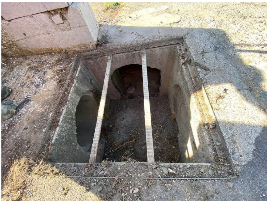
Foto 17 – Pozzetto grigliato esistente da pulire
