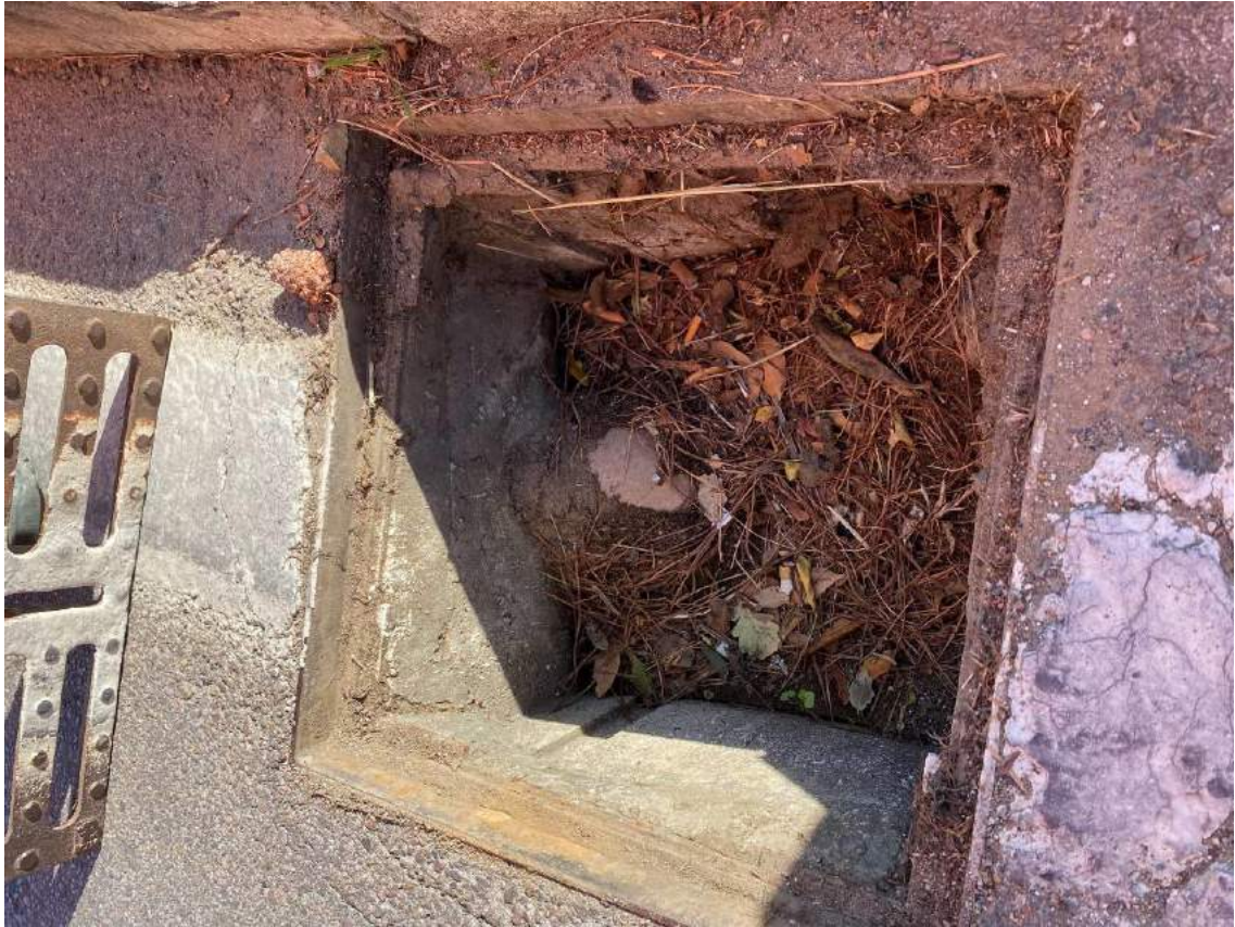
Foto 13 – Caditoia con griglia completamente intasato dai detriti al piede della Panooramica
