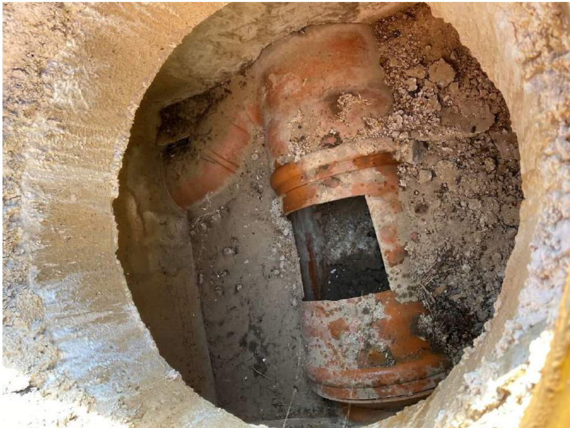
Foto 11 –Pozzetto fognatura acque meteoriche con elevate quantità di detriti nel collettore
