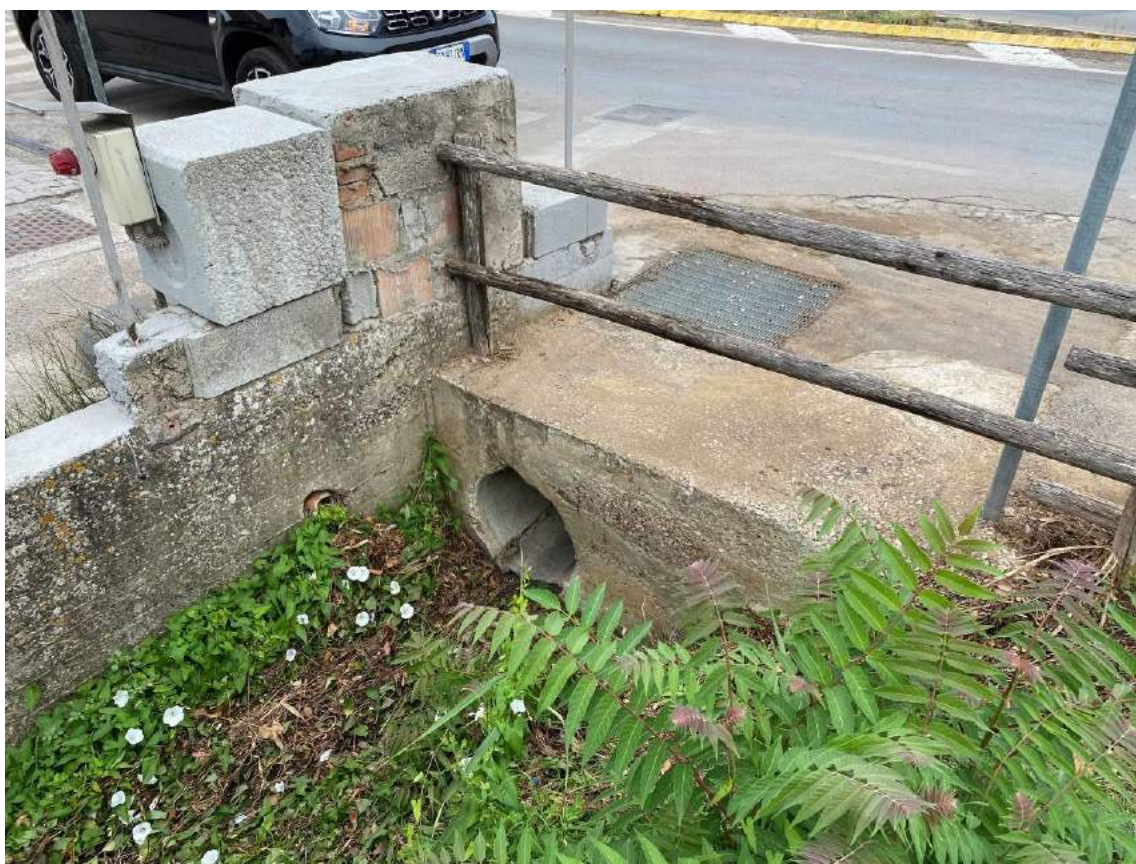
Foto 18 – Punto di scarico del nuovo collettore A nel Fosso esistente
