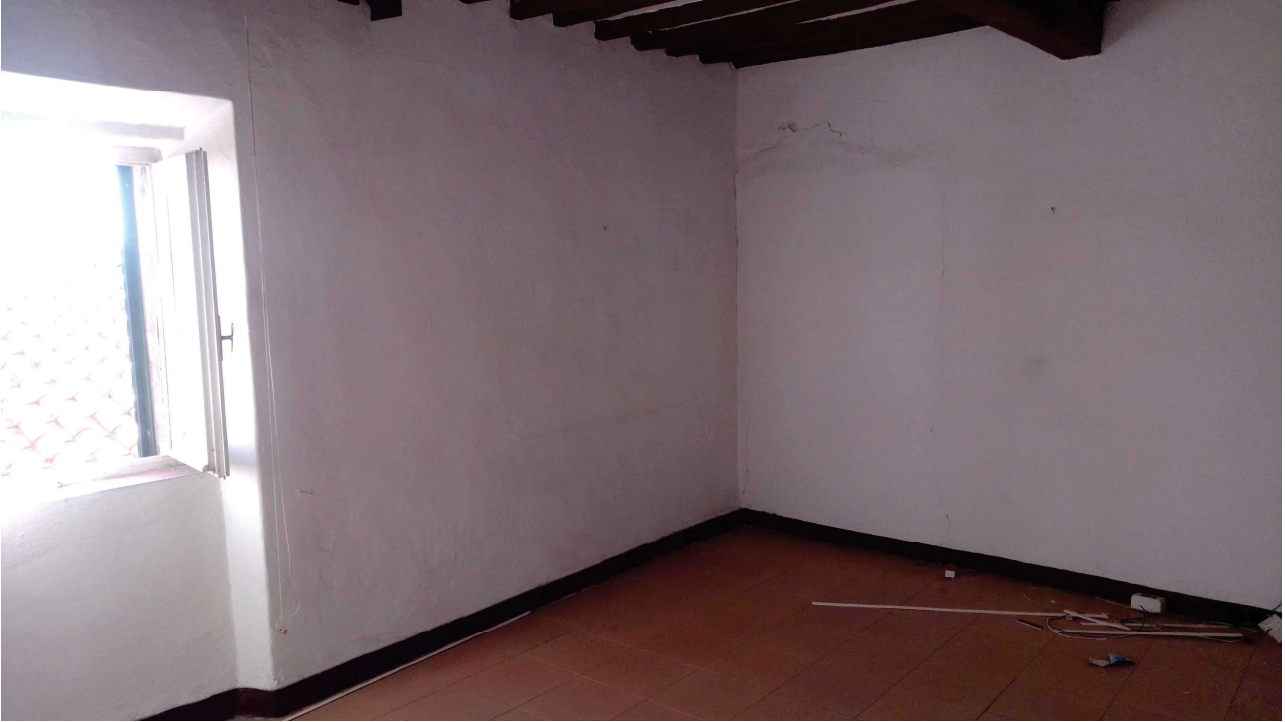
LOCALE LATO EST
