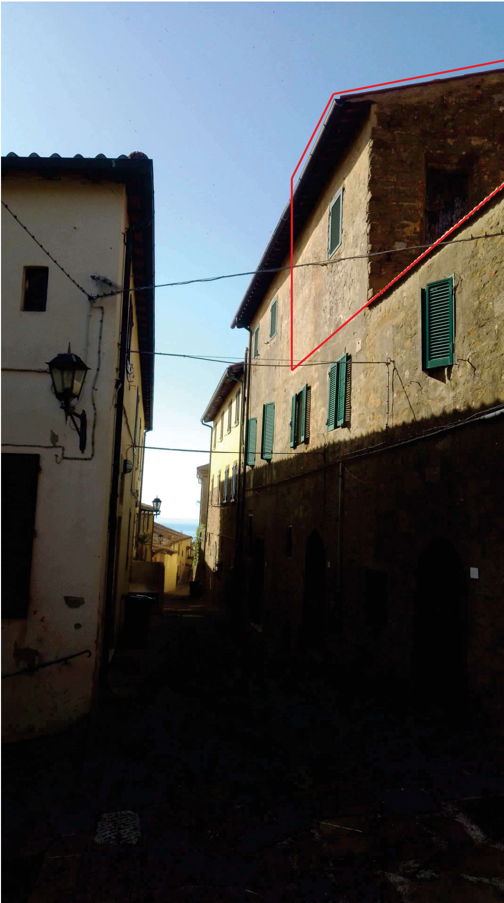
VISTA UNITA' IMMOBILIARE DA VIA DELL'OSPEDALE
