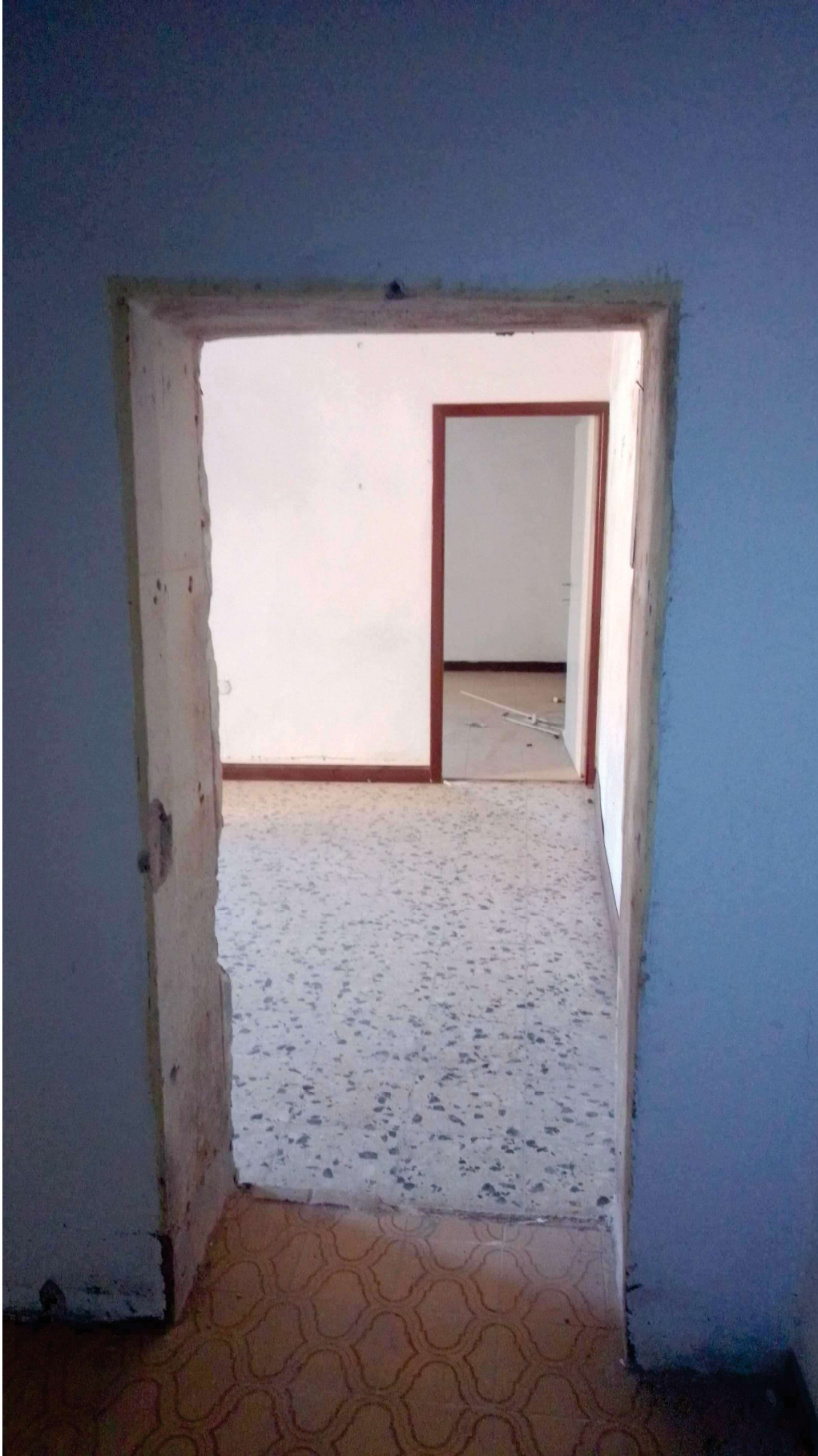
VISTA DA DISIMPEGNO D'INGRESSO SU LOCALE LATO NORD
