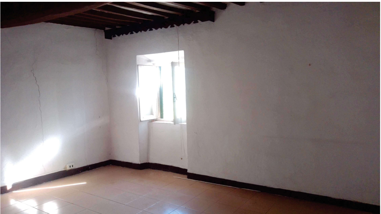
LOCALE LATO EST
