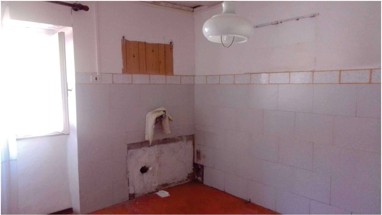
LOCALE CUCINA LATO OVEST
