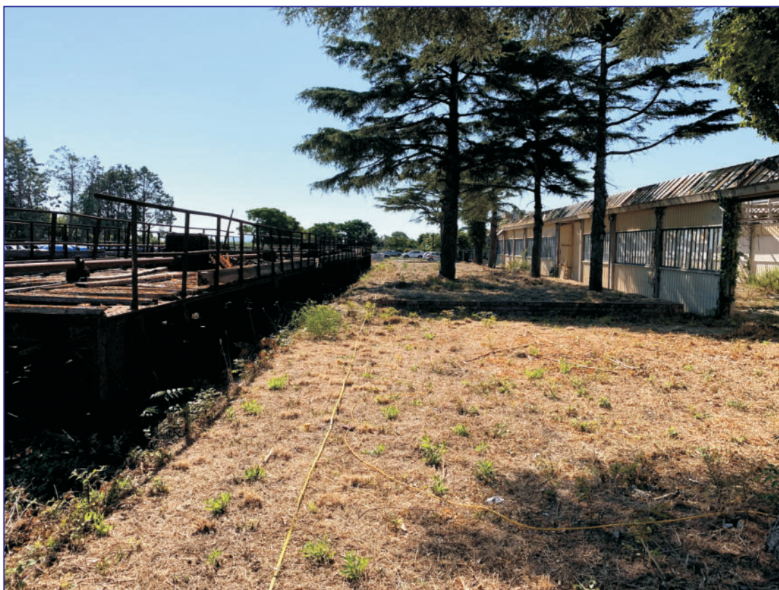
Vista da G1 verso G12 profilo sismico M2 configurazione ZVF
