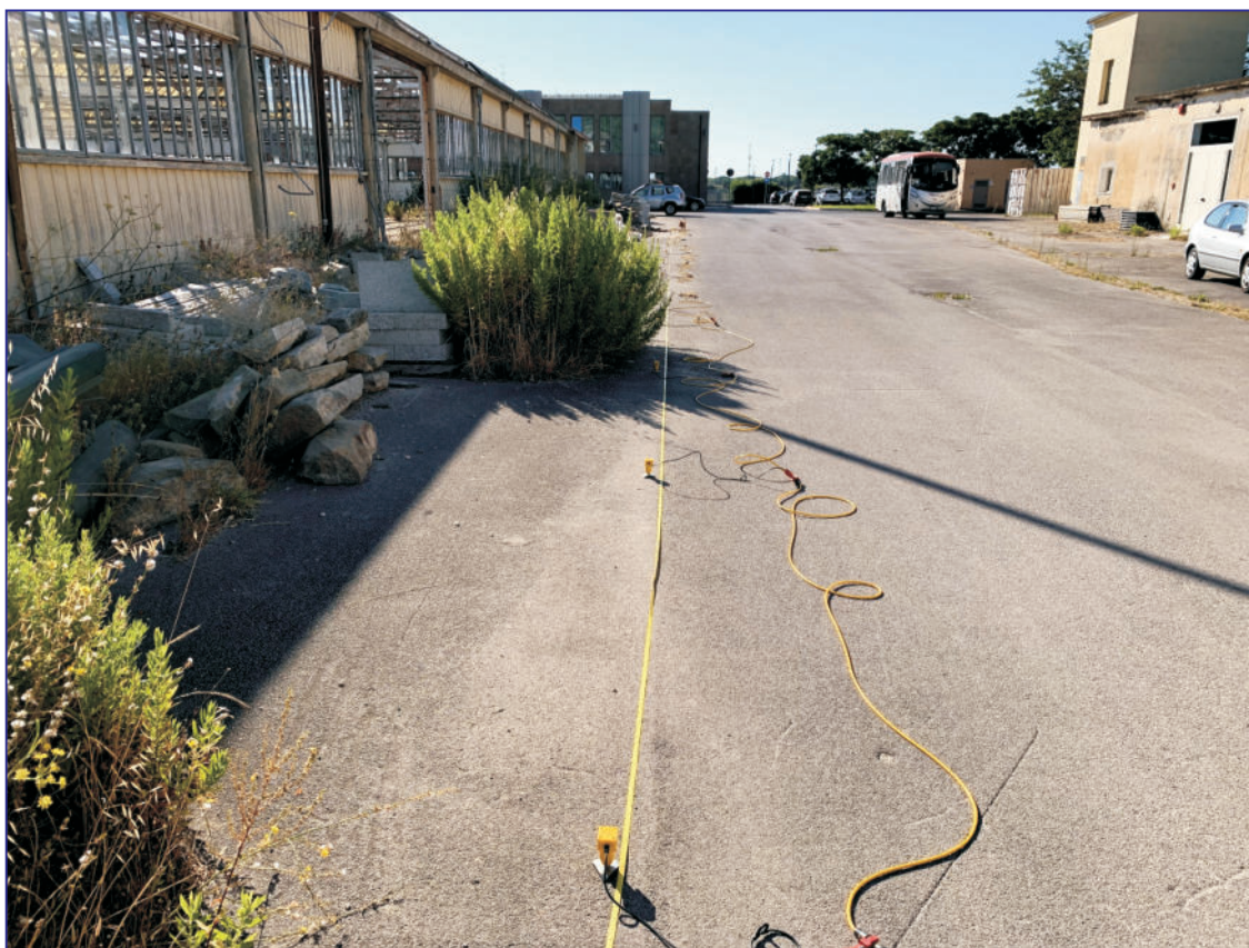
Vista da G1 verso G12 profilo sismico M1 configurazione ZVF
